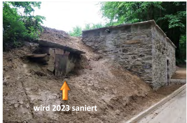
saniertes Keller Juli 2021
